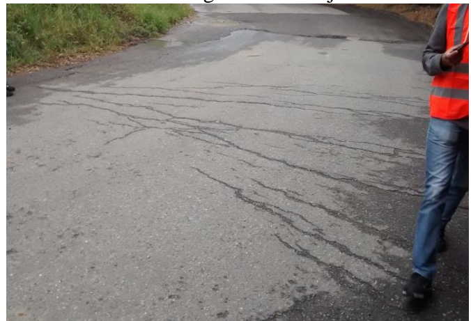
Foto 2. Fisuras transversales.
