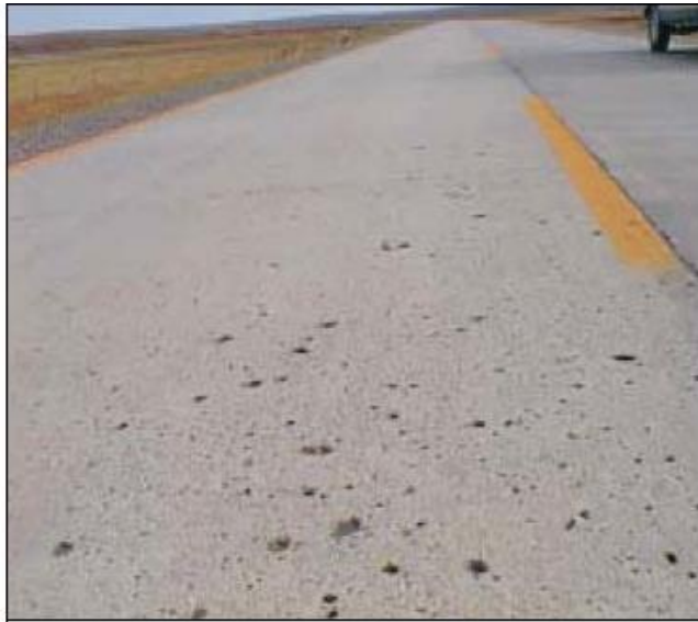
Foto 25. Descascaramiento.
