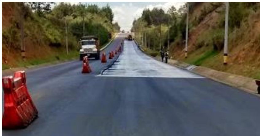
Ilustración 4. Tramo de vía a pavimentar.
