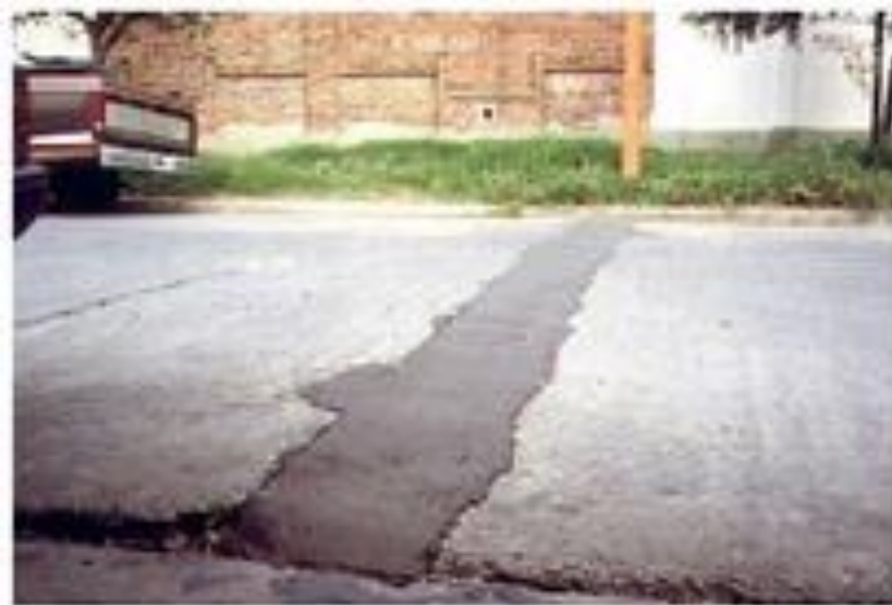
Foto 27. Levantamiento localizado.
