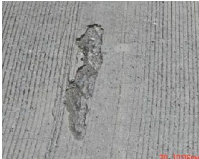
Foto 25. Descascaramiento.
