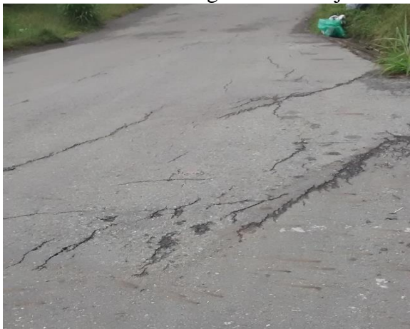
Foto1. Fisura longitudinal.
