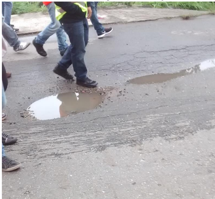
Foto 10. Hundimiento. Localización. Vía antigua hacia san jerónimo
