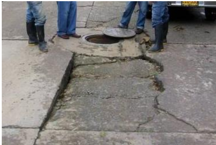
Foto 28. Hundimiento.
