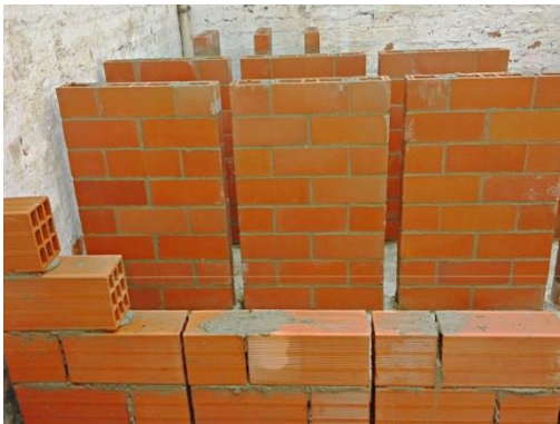
Foto 11. Construcción de muretes: Nivelación vertical.
