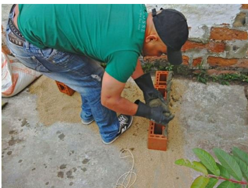
Foto 9. Construcción de muretes: Primera hilada.
