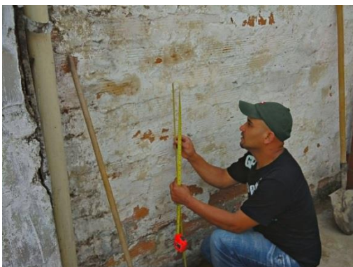
Foto 8. Construcción de muretes: Nivelación.
