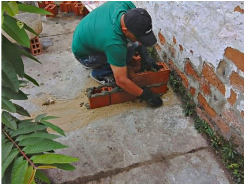
Foto 10. Construcción de muretes: Segunda hilada
