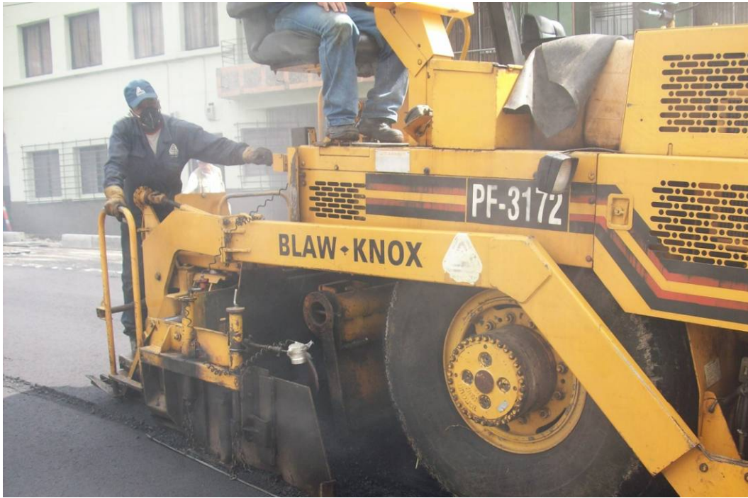
Anexo 2.15. Finisher regando material.
