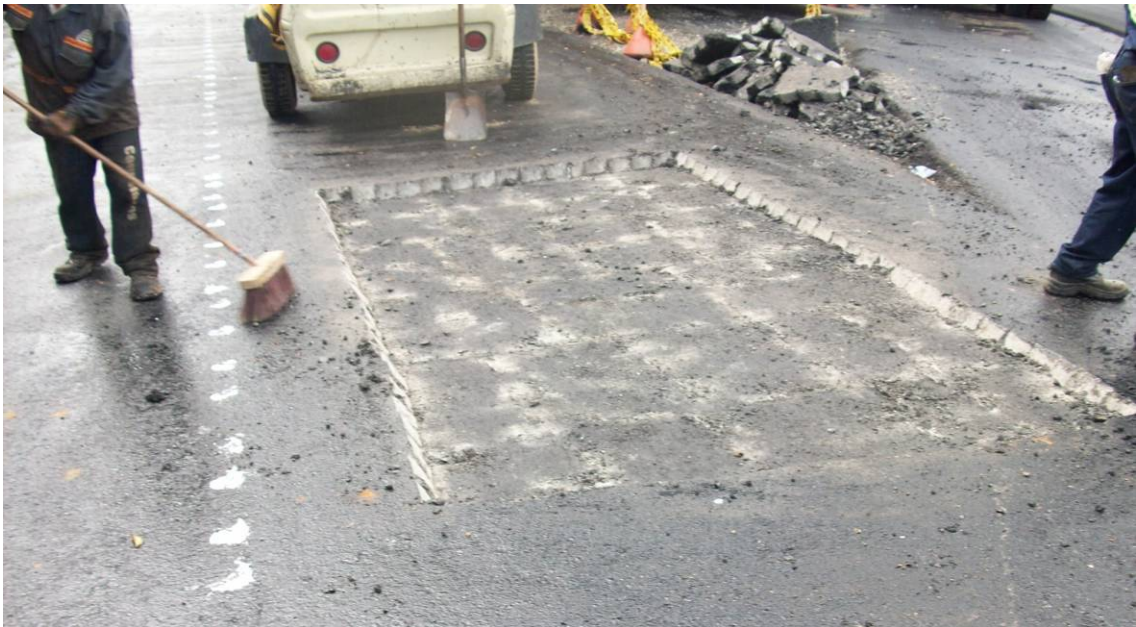
Anexo 2.12. Reemplazo de la carpeta asfáltica.
