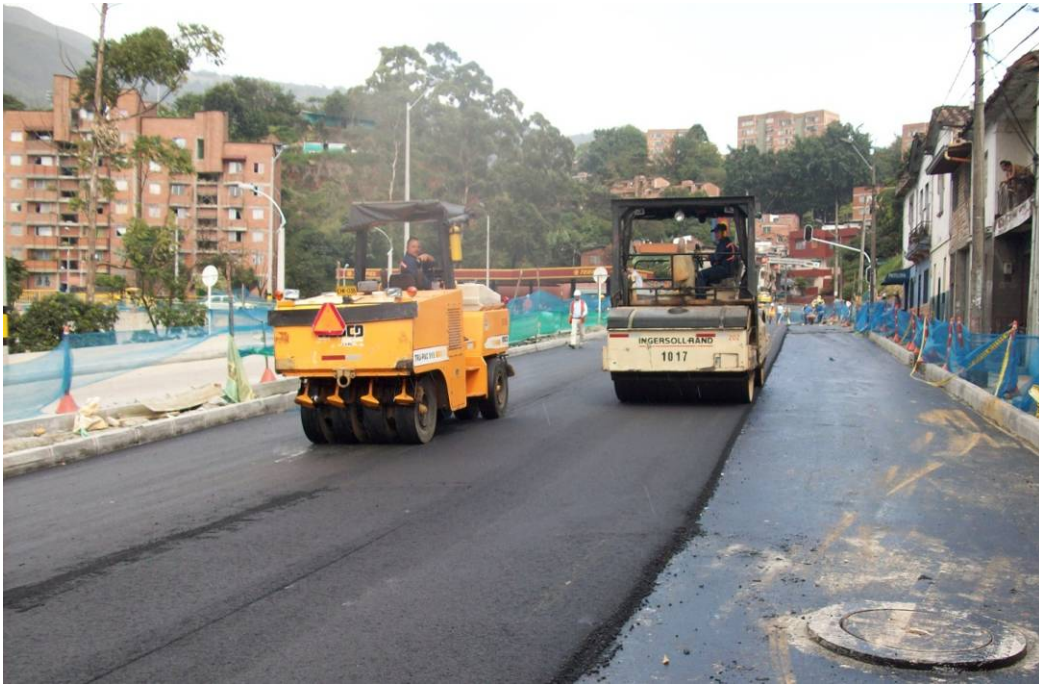
Anexo 2.13 Compactación de la carpeta asfáltica en el tramo 3.
