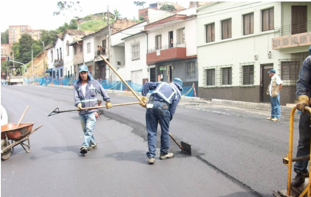
Anexo 2.14. Personal y equipo para riego de mezcla.
