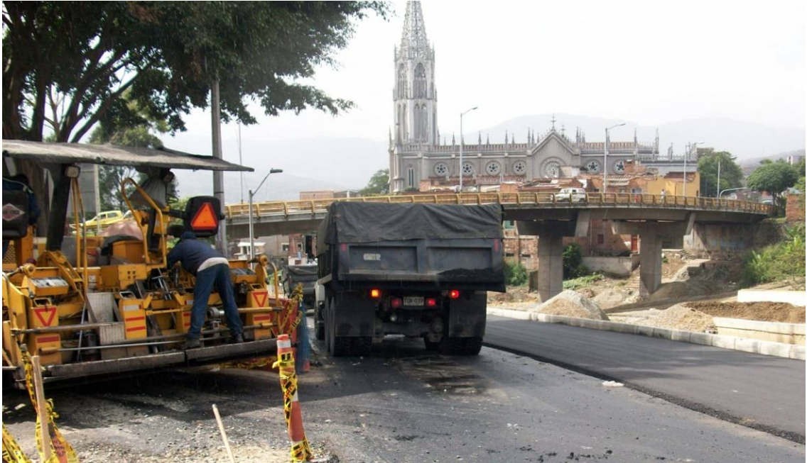
Anexo 2.11. Volquetas esperando para el riego del material, totalmente tapadas con carpas de lona)
