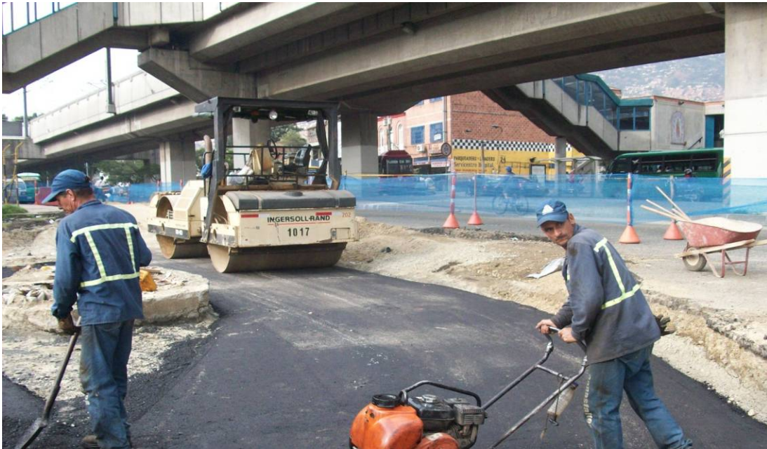
Anexo 2.7. Compactación de la carpeta (maquinaria) tramo 2.
