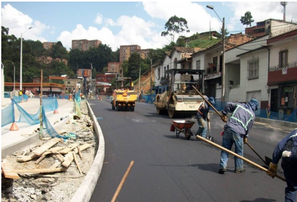
Anexo 2.16. Compactación y terminación de detalles.
