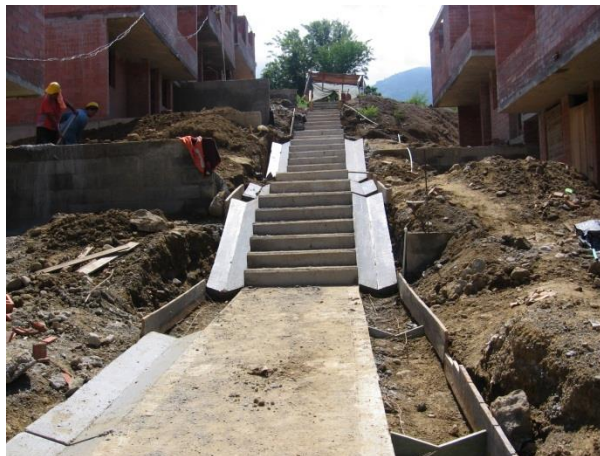
Figura 9 Andenes y cunetas Manzanas F y G Proyecto Buena Vista II
