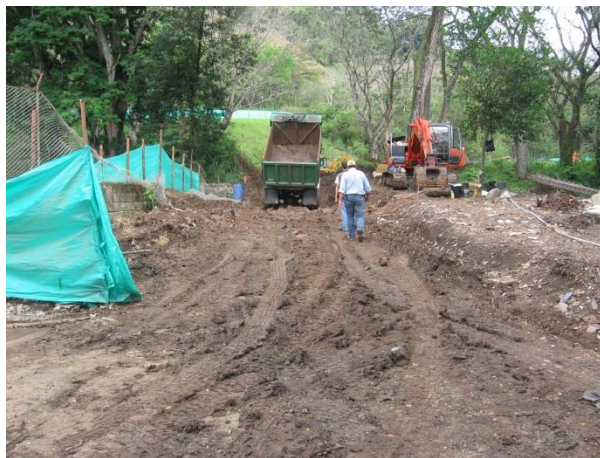
Figura 6 Movimiento de tierra
