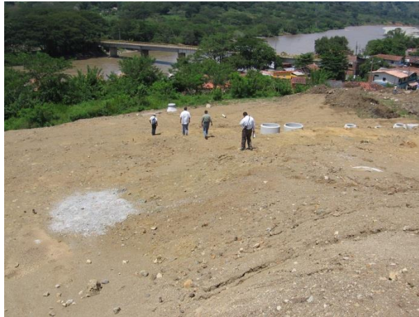
Figura 3 Conformación de terraza en lote Proyecto Buena Vista II
